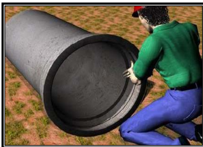
Figura 13 - Lubrificação do anel de borracha
