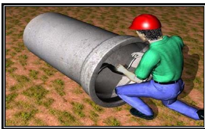
Figura 12 - Colocação do anel de borracha
