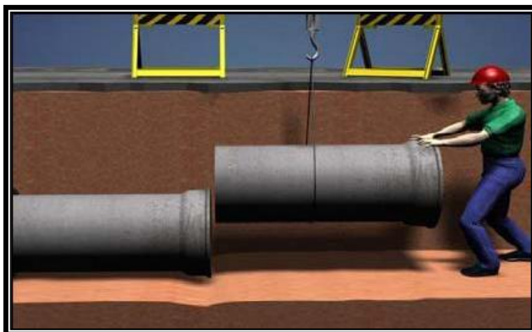
Figura 14 – Acoplamento de tubos de concreto
