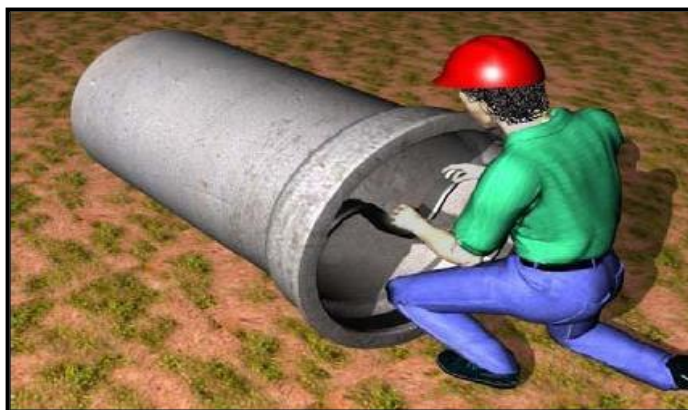
Figura 23 - Colocação do anel de borracha
