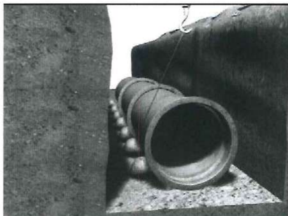
Figura 11 – Alinhamento dos tubos com uso de calços
