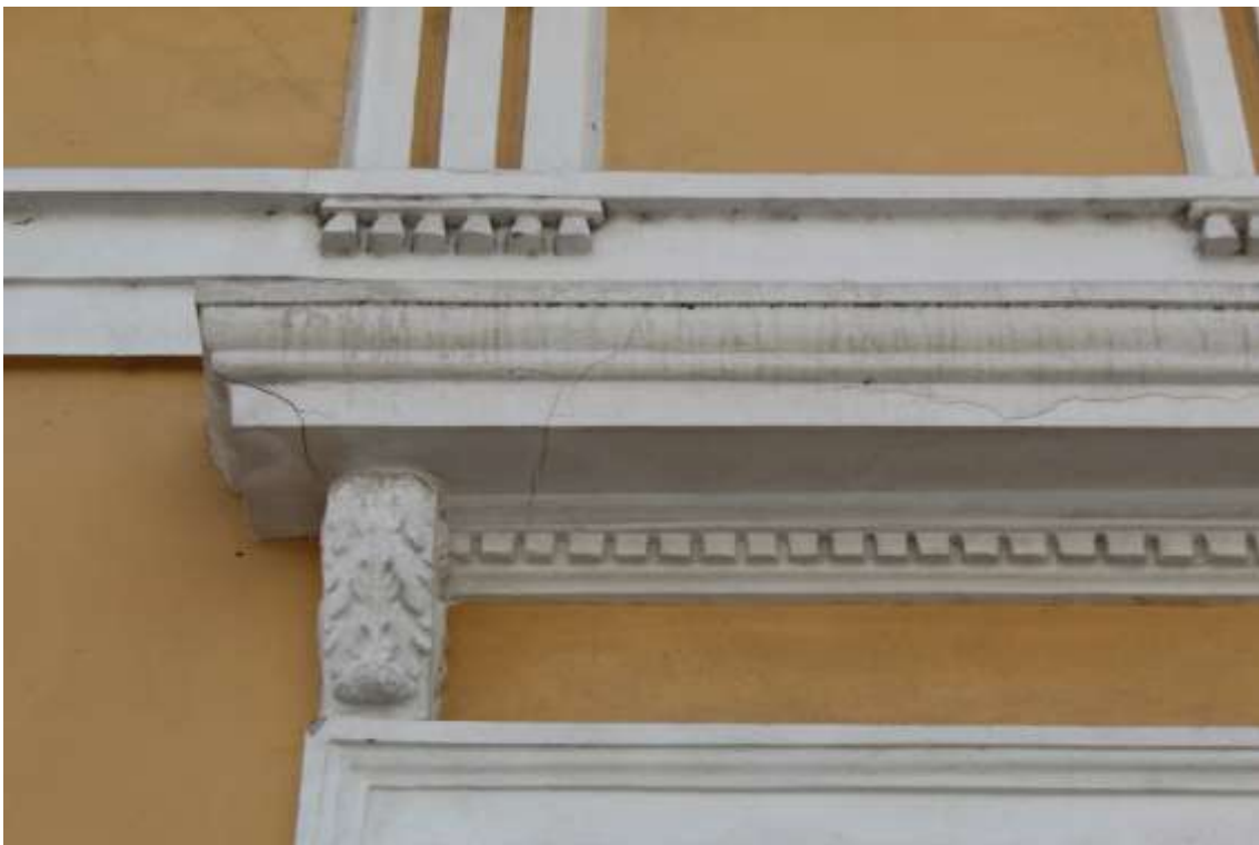
FIGURA 22 = FACHADA SUDESTE: fissuras na argamassa do ornamento
