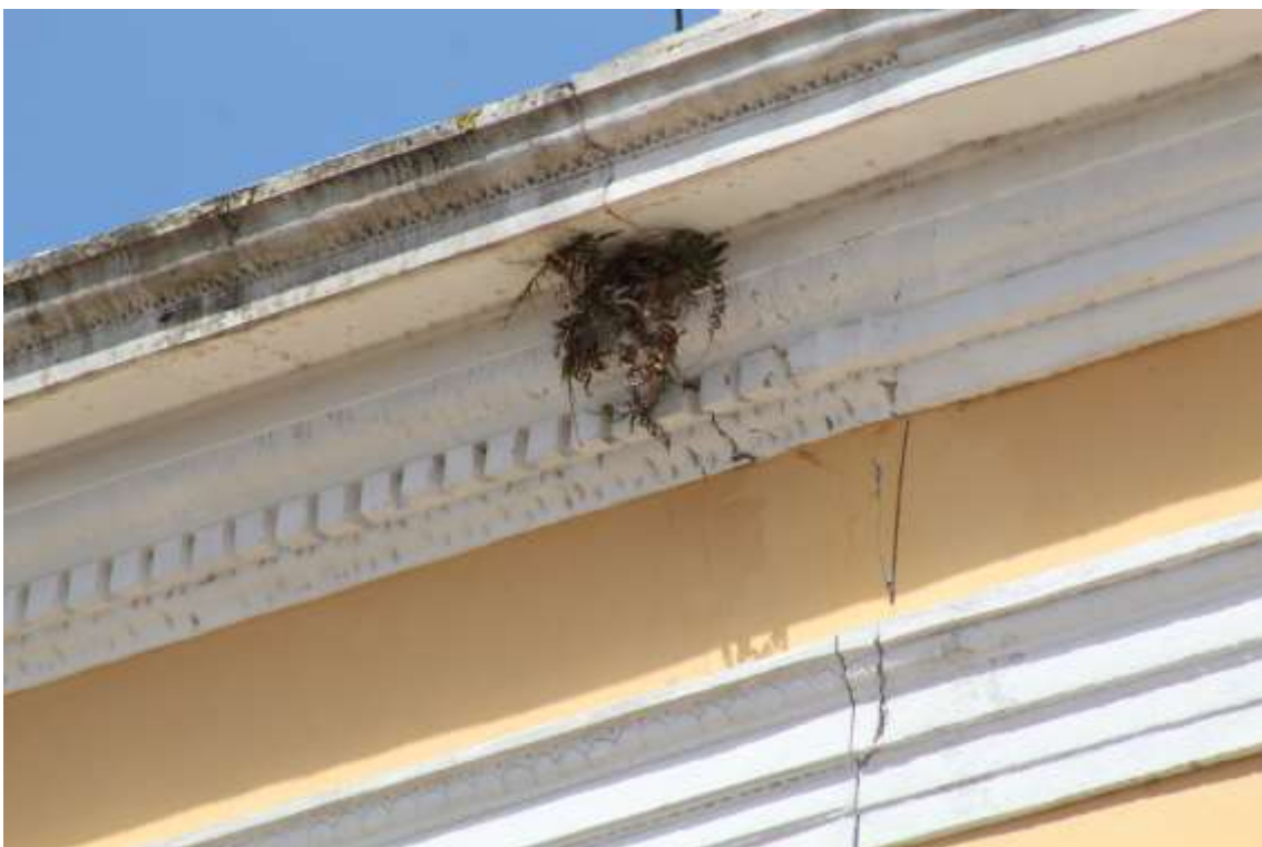
FIGURA 26 = FACHADA NOROESTE: vegetação a ser removida
