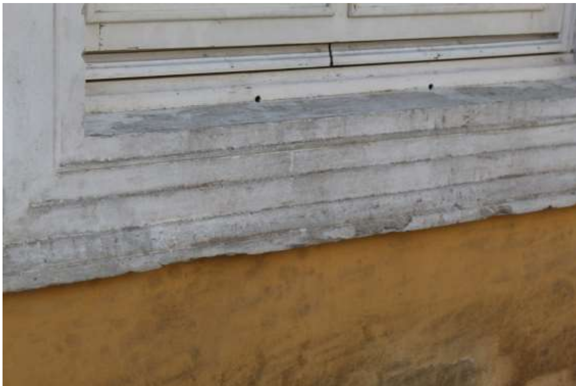
FIGURA 23 = FACHADA SUDESTE: moldura de argamassa avariada
