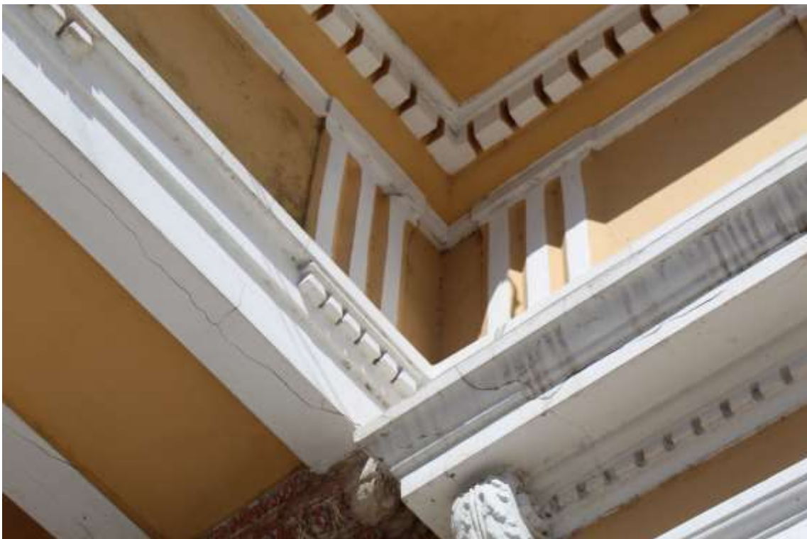
FIGURA 14 = FACHADA NORDESTE: ornamento da fachada e base do parlatório com fissuras
