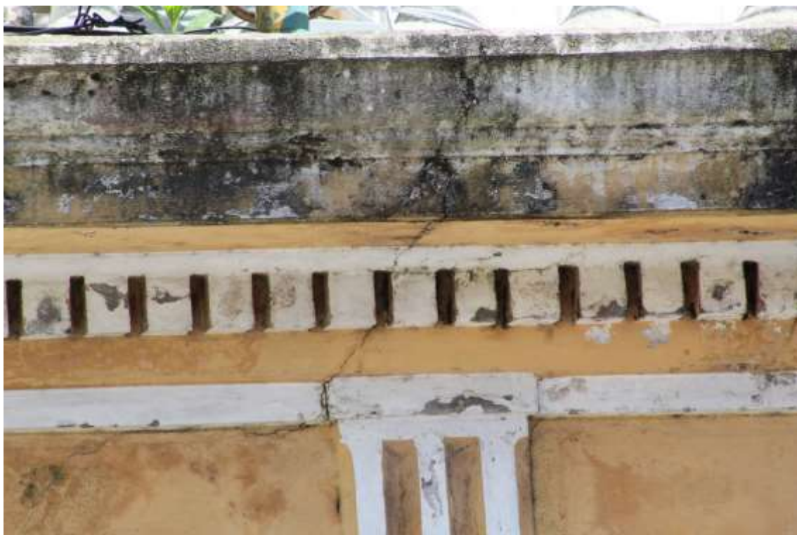
FIGURA 08 = FACHADA NORDESTE: fissura no reboco do parlatório.
