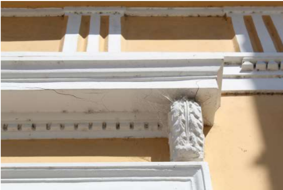
FIGURA 15 = FACHADA NORDESTE: fissuras na argamassa do ornamento
