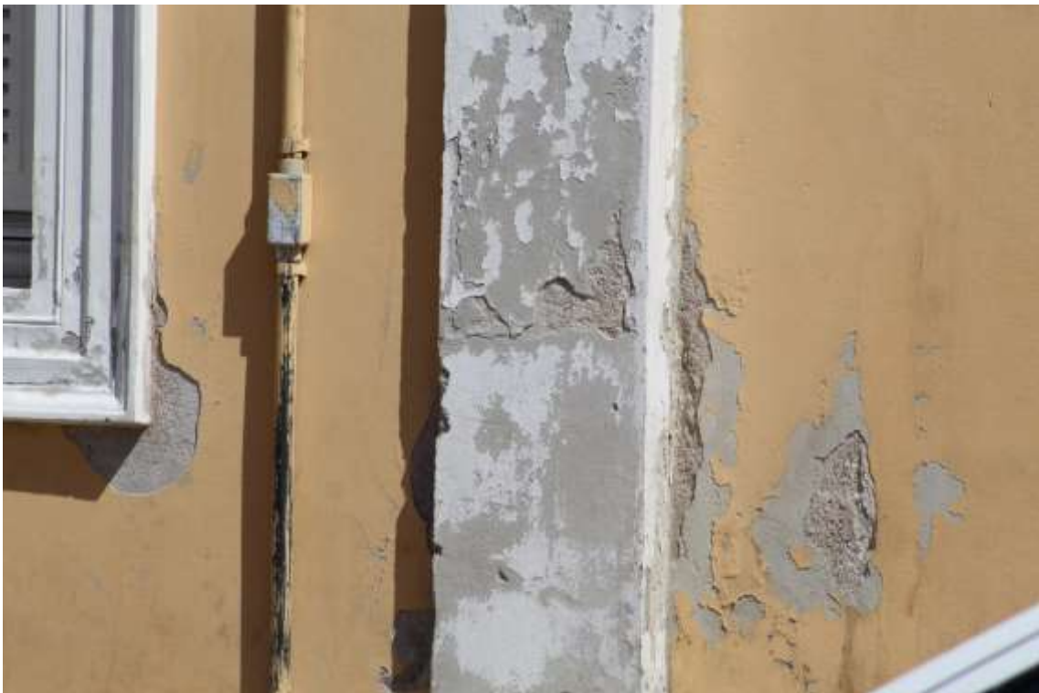
FIGURA 04 = FACHADA NORDESTE: pontos de deslocamento do reboco.
