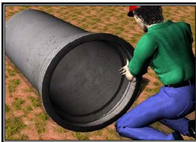
Figura 14 - Lubrificação do anel de borracha
