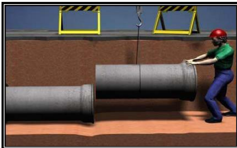
Figura 15 – Acoplamento de tubos de concreto
