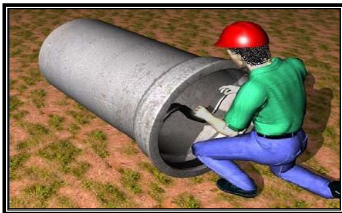
Figura 13 - Colocação do anel de borracha
