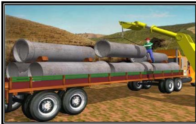
Figura 11 - Descarregamento dos tubos
