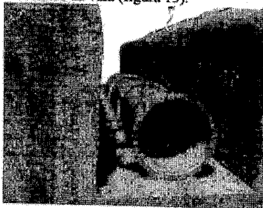
Figura 13- Alinhamento dos tubos com uso de calços
