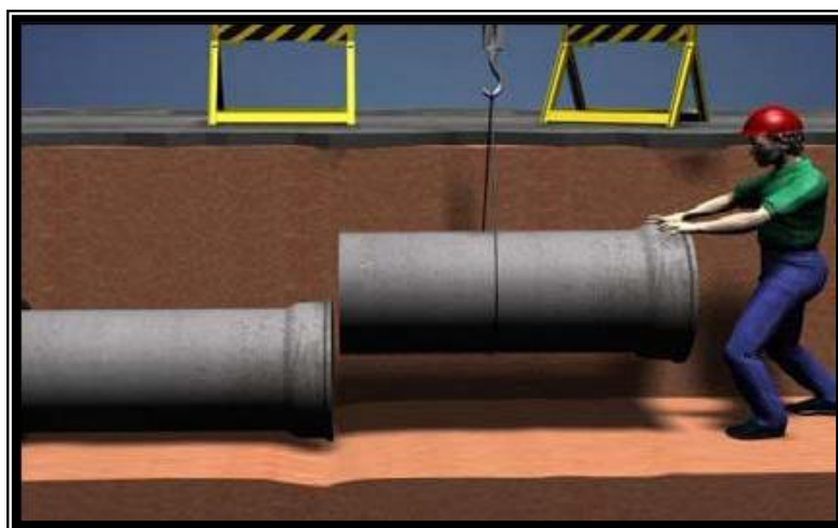
Figura 27 – Acoplamento de tubos de concreto
