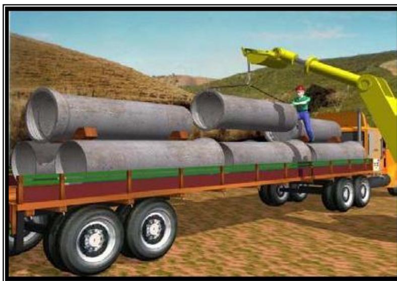
Figura 23 - Descarregamento dos tubos
