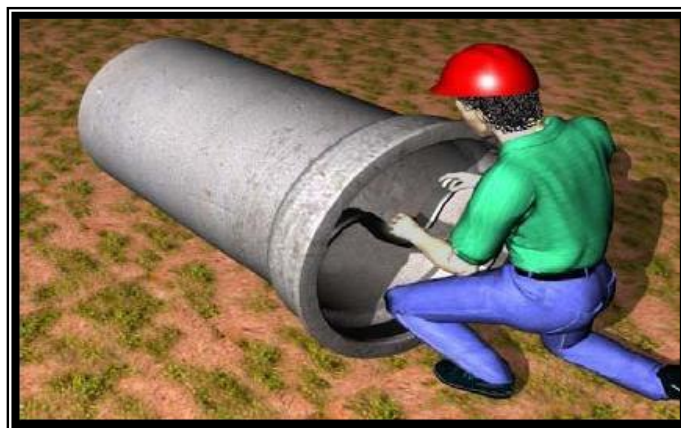
Figura 25 - Colocação do anel de borracha
