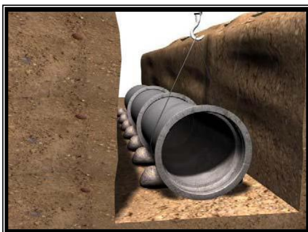
Figura 28 – Alinhamento dos tubos com uso de calços
