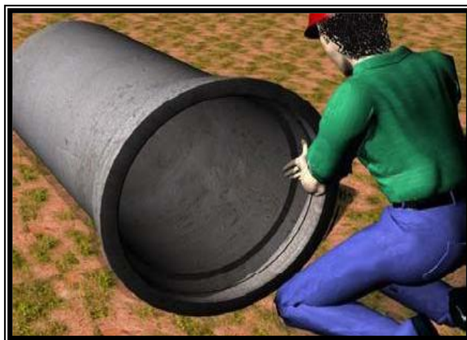
Figura 26 - Lubrificação do anel de borracha
