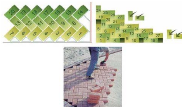
Figura 15 – Padrão de assentamento tipo espinha de peixe.
