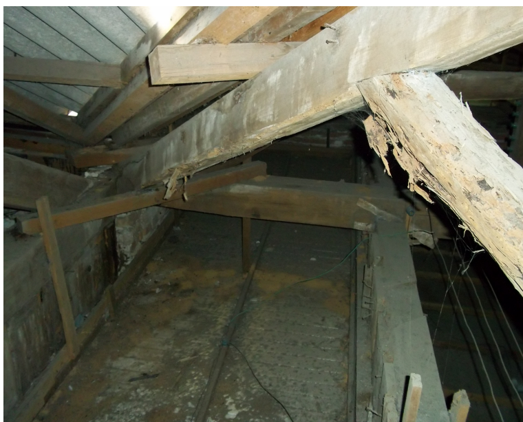
Peça do madeiramento a substituir (sem recuperação).
