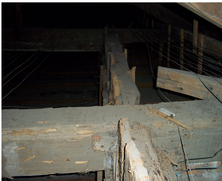
Peças a substituir ou com secção a reduzir.
