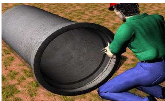
Figura 11 - Lubrificação do anel de borracha
