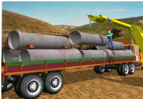
Figura 08. Descarregamento dos tubos
