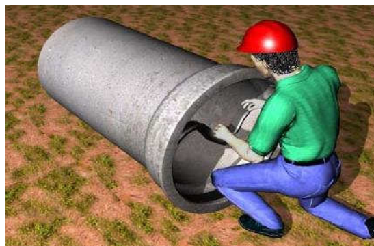
Figura 10- Colocação do anel de borracha
