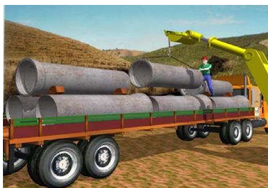
Figura 08. Descarregamento dos tubos
