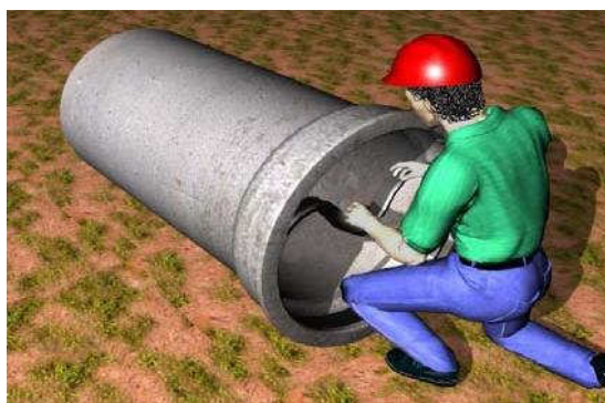
Figura 10- Colocação do anel de borracha
