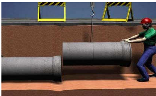
Figura 11– Acoplamento de tubos de concreto
