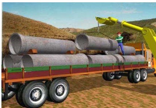
Figura 07. Descarregamento dos tubos
