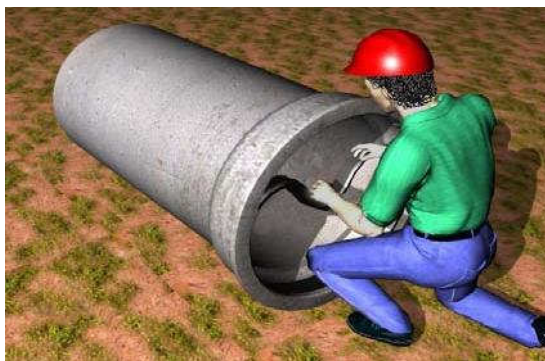
Figura 09- Colocação do anel de borracha
