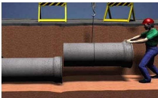
Figura 11– Acoplamento de tubos de concreto
