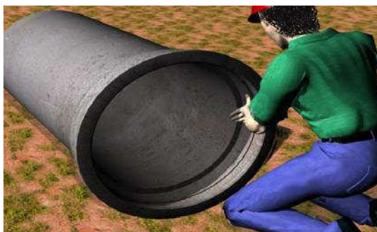
Figura 10 - Lubrificação do anel de borracha
