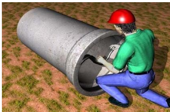
Figura 09- Colocação do anel de borracha
