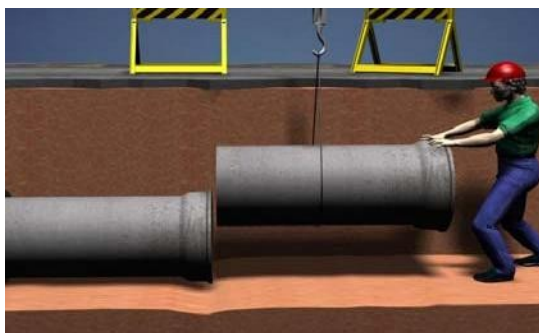
Figura 11– Acoplamento de tubos de concreto
