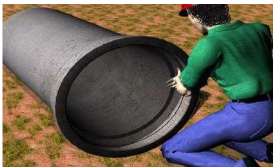
Figura 11 - Lubrificação do anel de borracha
