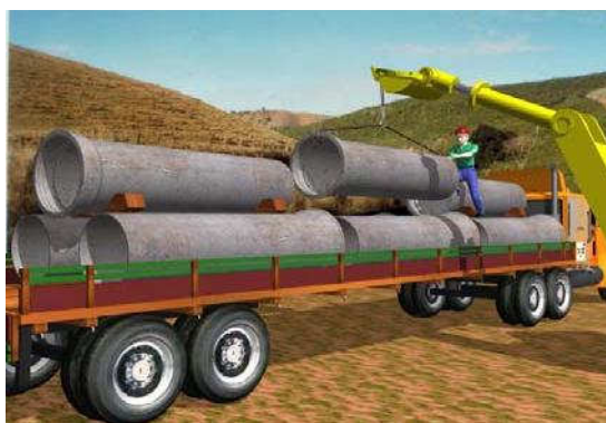
Figura 08. Descarregamento dos tubos
