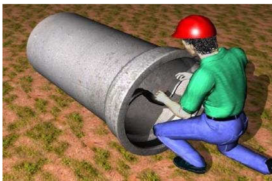
Figura 10- Colocação do anel de borracha
