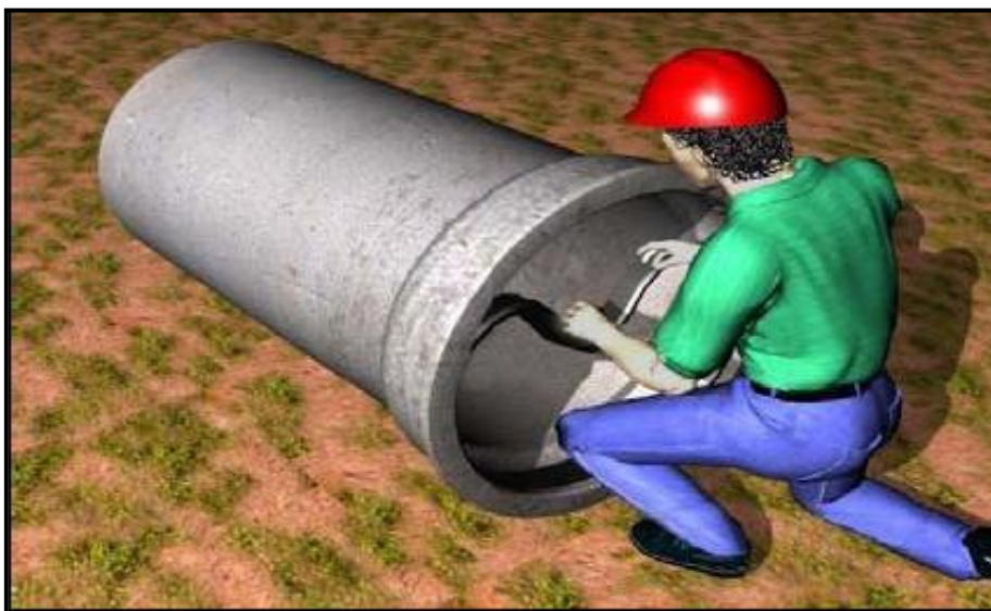
Figura 12 - Colocação do anel de borracha
