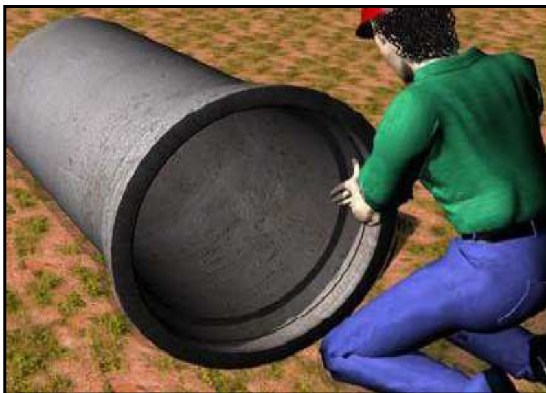
Figura 12 - Lubrificação do anel de borracha
