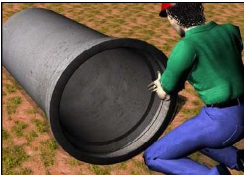
Figura 13 - Lubrificação do anel de borracha
