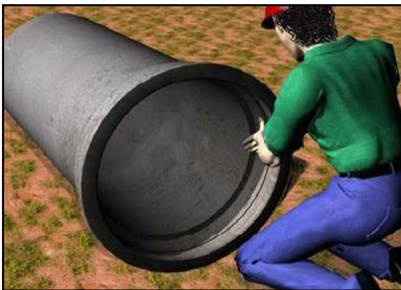
Figura 13 - Lubrificação do anel de borracha
