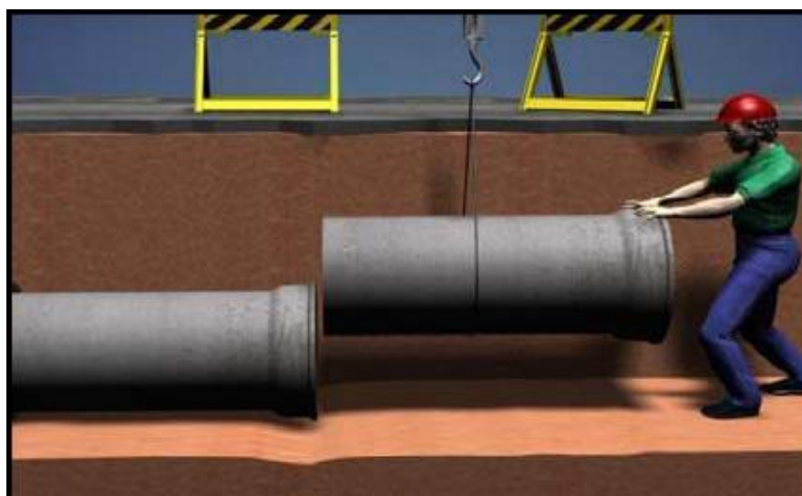
Figura 14 – Acoplamento de tubos de concreto
