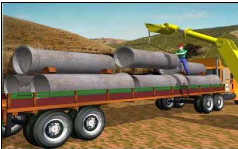
Figura 9 - Descarregamento dos tubos
