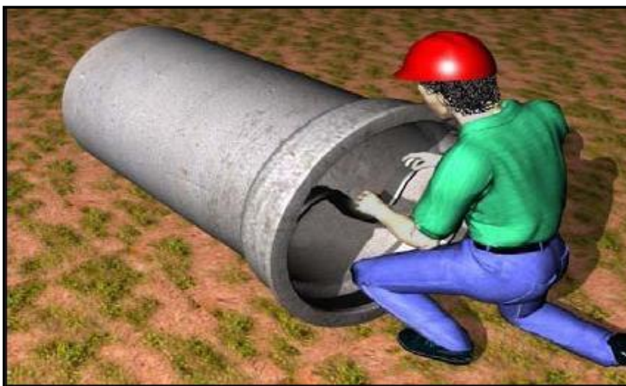
Figura 12 - Colocação do anel de borracha
