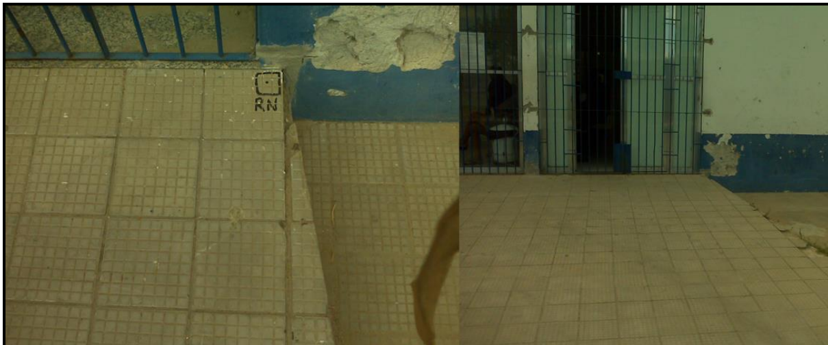
Figura 1 – RN implantado no piso.
