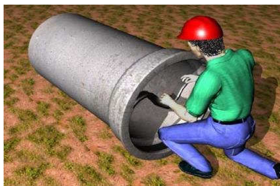
Figura 10- Colocação do anel de borracha
