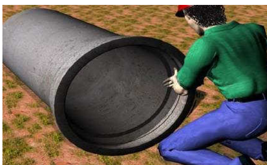
Figura 11 - Lubrificação do anel de borracha
