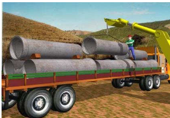
Figura 08. Descarregamento dos tubos
