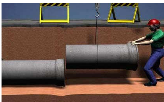
Figura 12– Acoplamento de tubos de concreto
