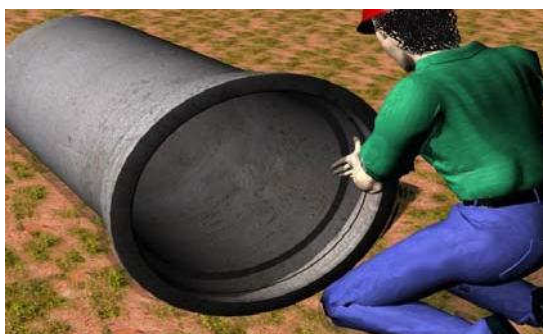
Figura 11 - Lubrificação do anel de borracha
