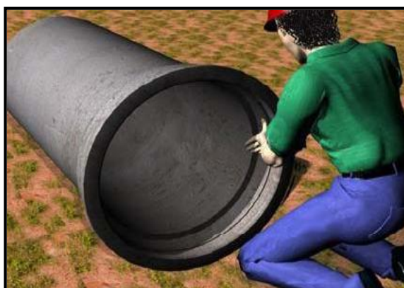
Figura 23 - Lubrificação do anel de borracha
