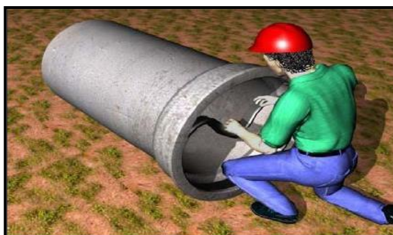
Figura 22 - Colocação do anel de borracha
