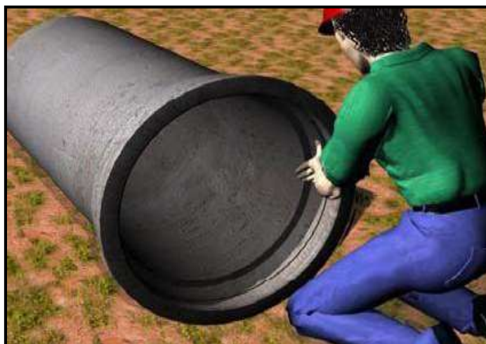
Figura 28 - Lubrificação do anel de borracha
