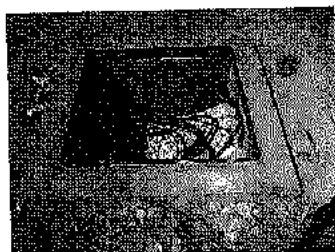
Figura 59: Imagem referência - Caixa de alvenaria de passagem 80cmx80cmx70 e tampa de 50cmx50cmx60cm.
