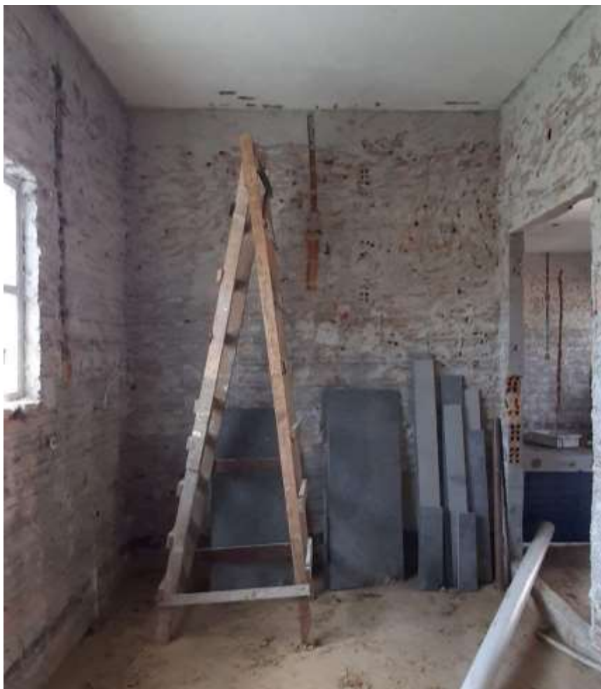
Figura 16 – Rasgo vertical na parede, deverá interligar a tubulação a 30 cm do piso.
