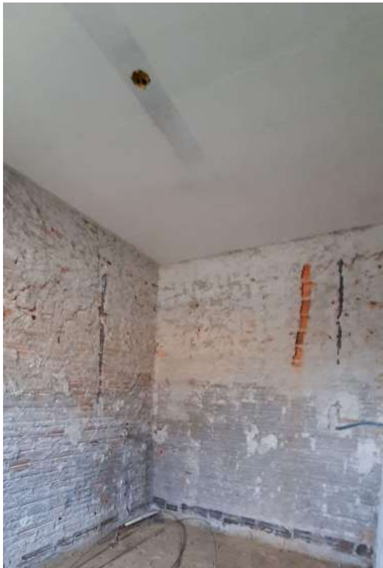
Figura 09 – Caixa octagonal existente para Ponto de Iluminação e conexão eletroduto PEAD (circuitos elétricos QGBT).
