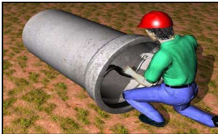
Figura 7 - Colocação do anel de borracha
