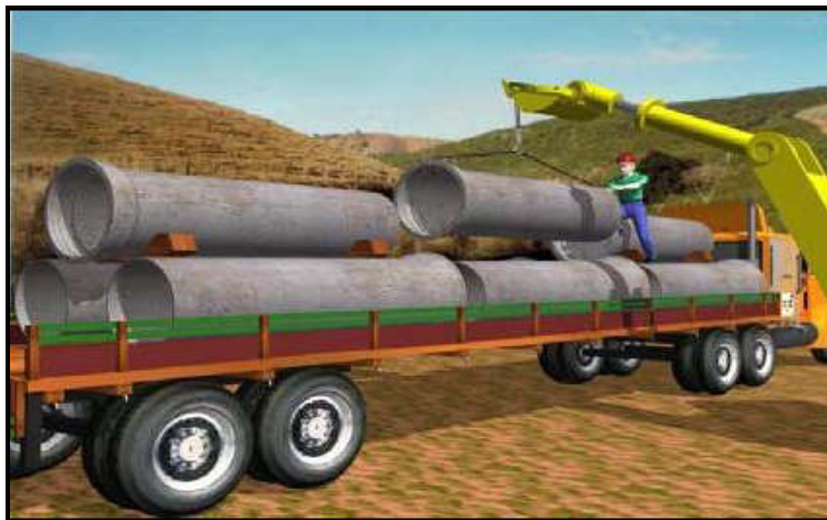
Figura 5 - Descarregamento dos tubos
