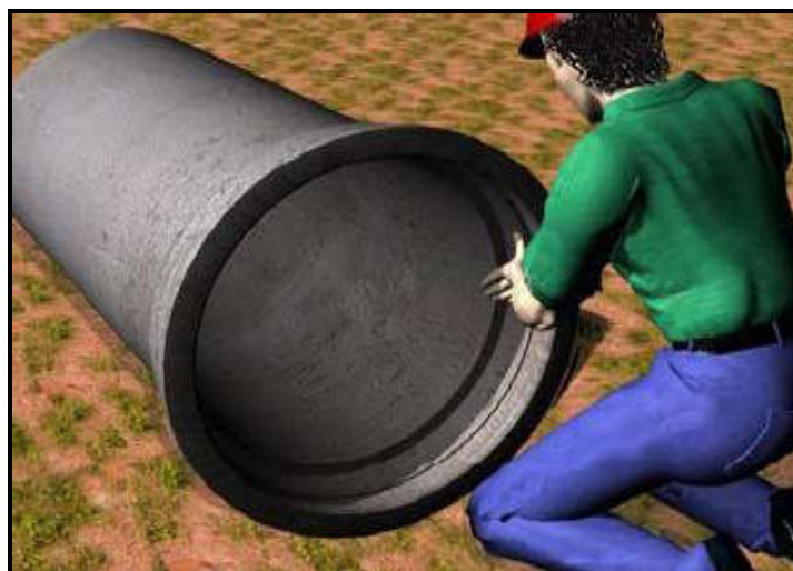
Figura 8 - Lubrificação do anel de borracha
