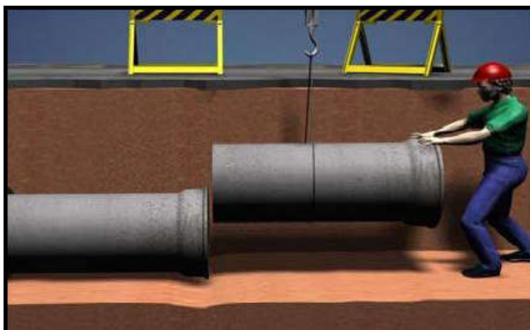
Figura 9 - Acoplamento de tubos de concreto
