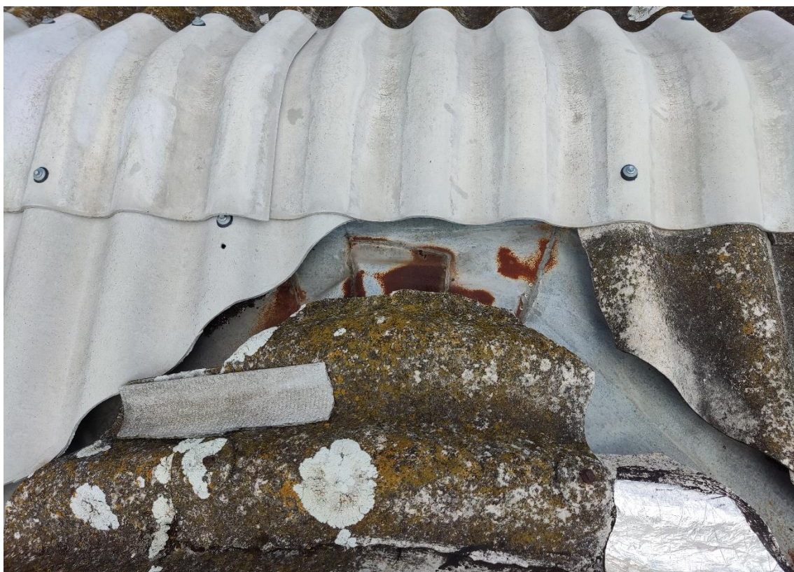
Figura 3 – Telhas completamente quebradas no encontro das águas do telhado (água furtada)
