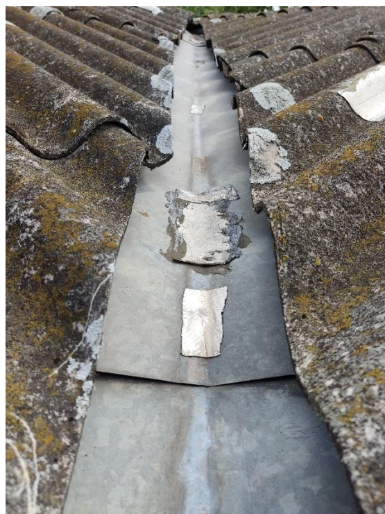
Figura 7 – Calha com pontos de infiltração
