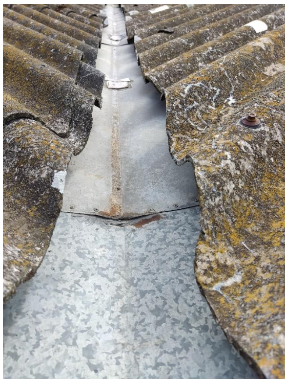
Figura 6 – Calha com pontos de infiltração
