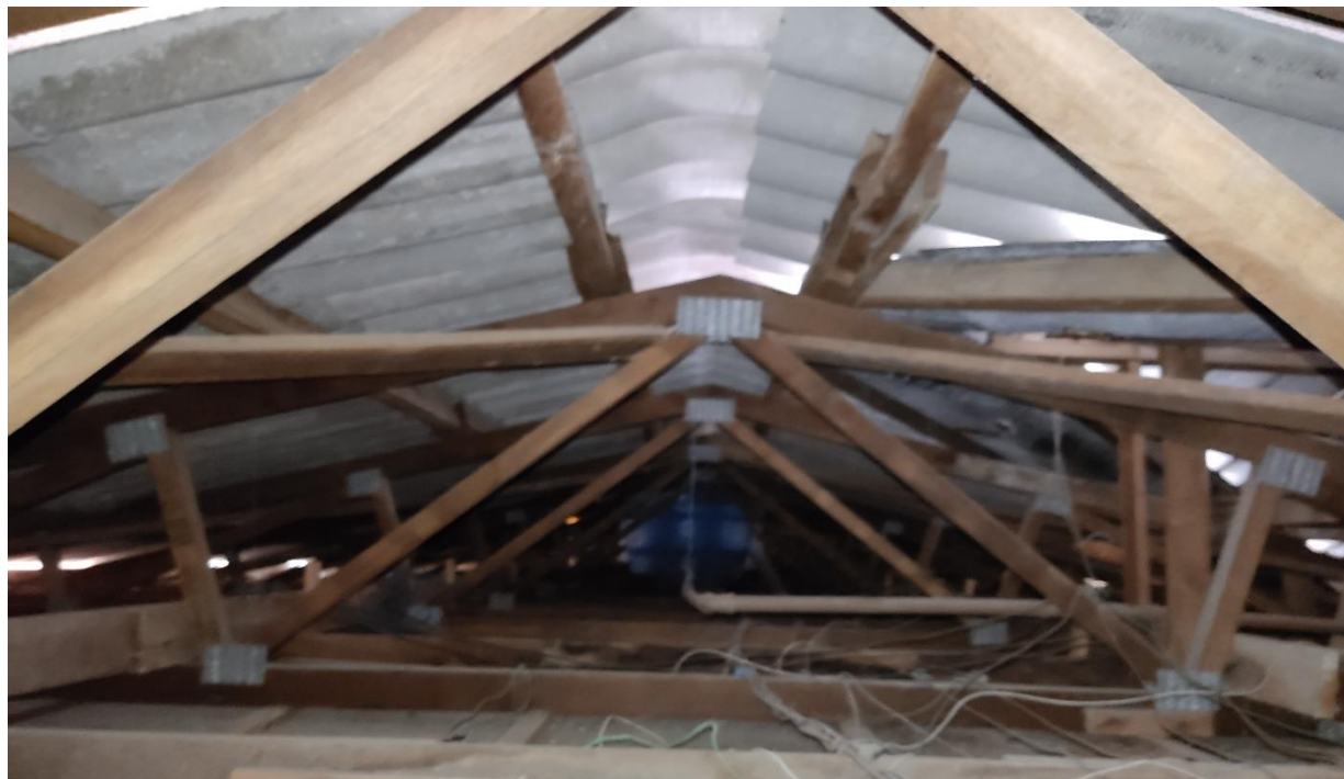
Figura 8 – Madeiramento em bom estado de conservação
