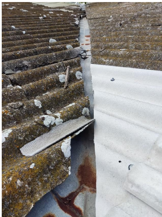
Figura 4 – Água furtada
