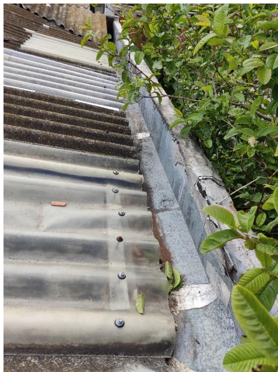
Figura 5 – Calha rasa
