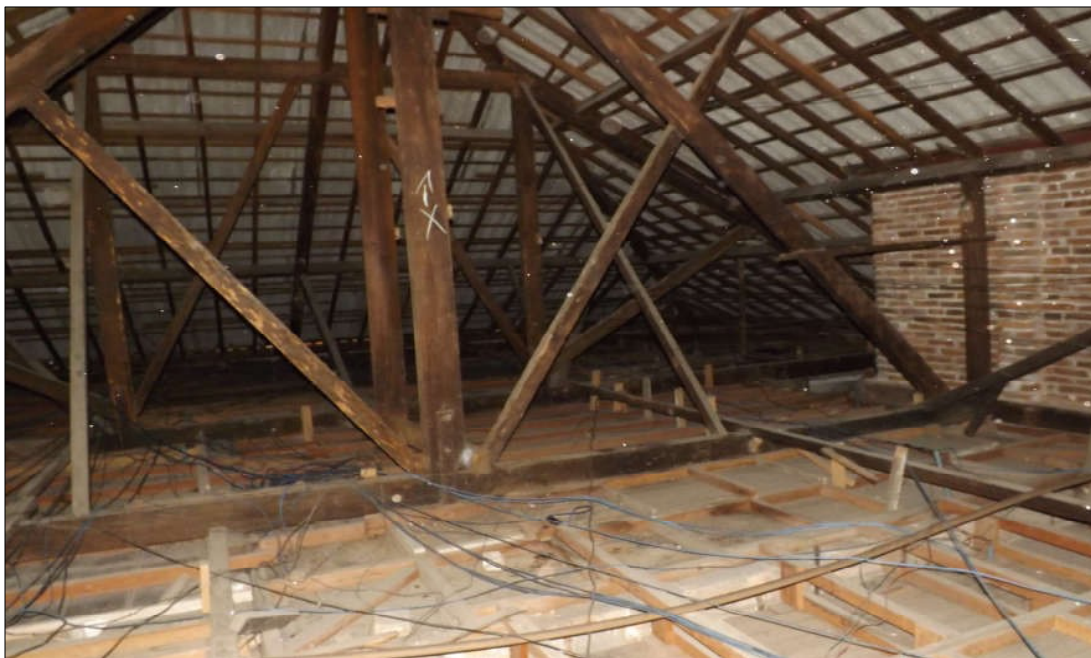
Foto 02: Vista parcial referente ao telhado de 4 águas.
