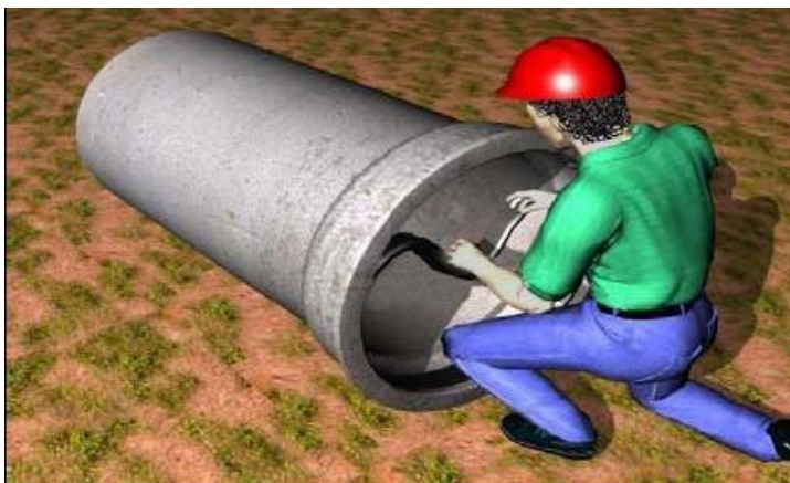
Figura 12 - Colocação do anel de borracha
