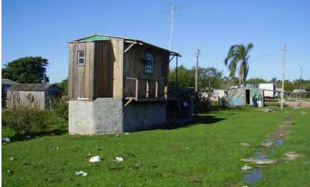
Figura 5.8: Medo dos efeitos destrutivos da maré registrado na forma da construção da edificação pelos moradores locais
