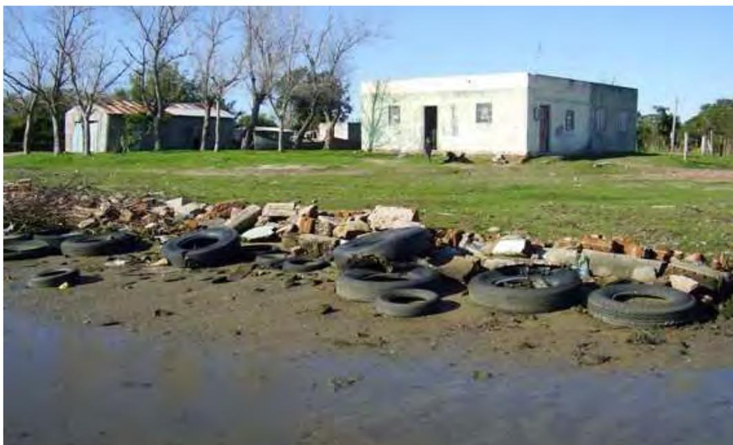
Figura 5.7: Tentativa de contenção da erosão com calça e pneus (PDMI, 2006)
