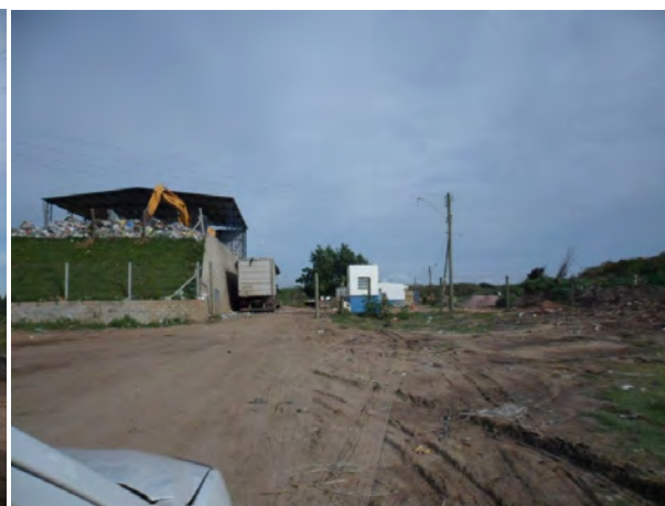
Figura 4.28: Estação de Transbordo
