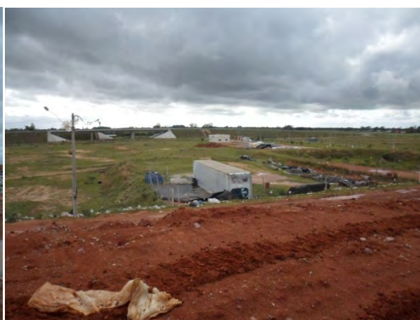
Figura 4.35: Vista do aterro sanitário
